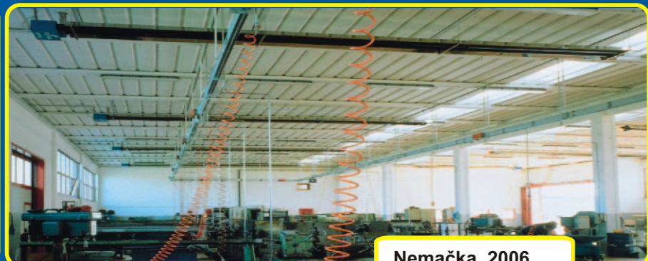
Nemačka, 2006 proizvodna hala
